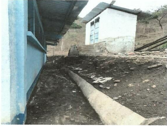
Foto 1: SERVICIOS SANITARIOS Y SUS ACCESORIOS
