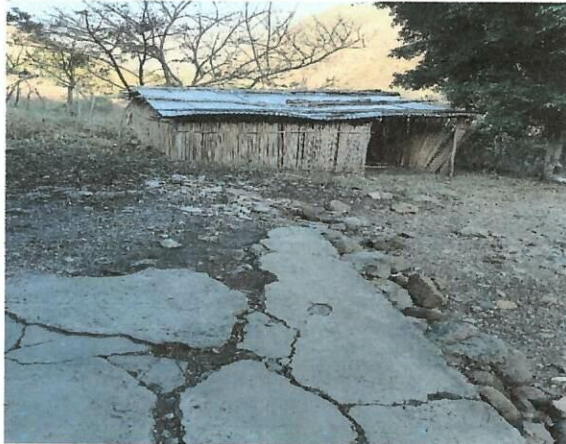
Foto 3: REPARACION O SUSTITUCION DE AREA DE COCINA (ESTUFAS RURALES, PILAS, VENTANAS, PUERTAS, CHIMENEAS, ETC.)
